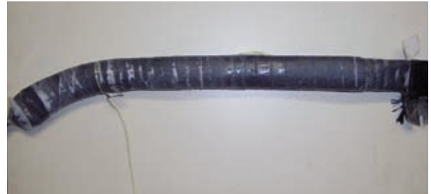
(Bild 25 Verstärkungslagen laminiert)
