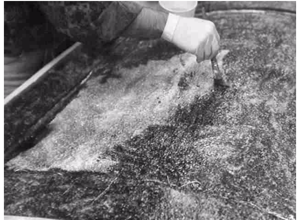
Foto 35: Die Kopplungsschicht wird aufgetragen
