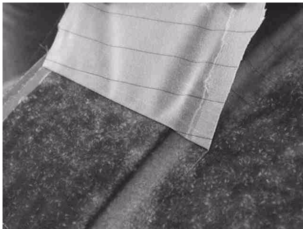
Foto 38: Das Abreißgewebe wird 24 h später entfernt
