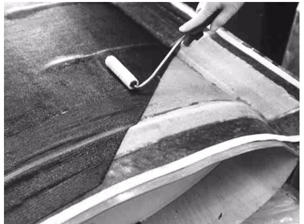
Foto 59: Nach 24 h wird das Kohlefasergerewebe laminiert - Faserrichtung 0°/90°
