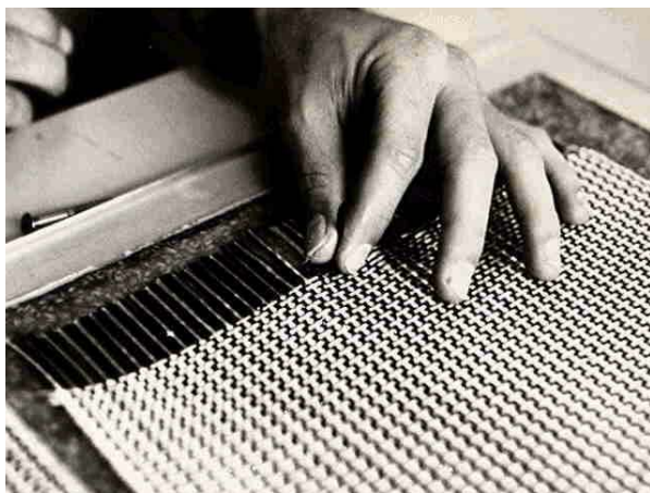
Foto 4: Das Heizgewebe wird aufgelegt und die Kohlefaserstränge 3 cm bis 5 cm freigelegt
