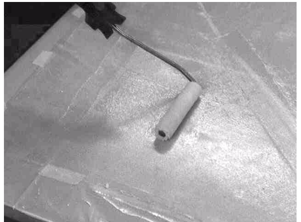
Foto 65: Die Glasfasergewebe für die äußeren Decklagen werden auf Folie vorlaminieren, ...
