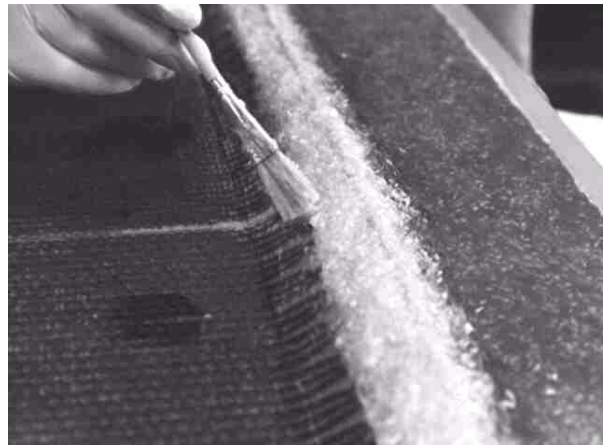
Foto 53: Die Isolierung der Stromführung
