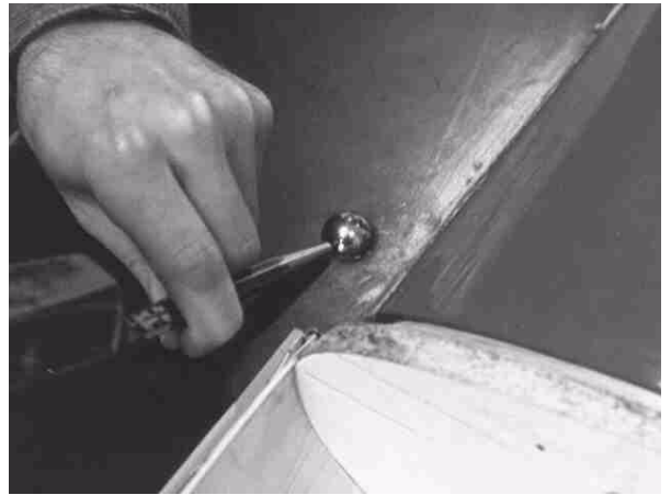
Foto 70: Die Kugellagerkugeln werden mit Hammer ...
