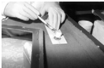
Aufbringen gefüllter Harze mit Pinsel/Spritztüte
