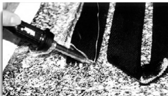
Verlöten der Aderendhülsen am Kohleband
