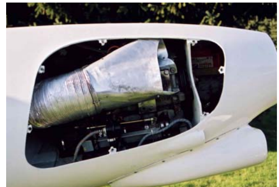
Bild 5.35: Kühlkanal aus Aluminium um die Auspuffanlage
