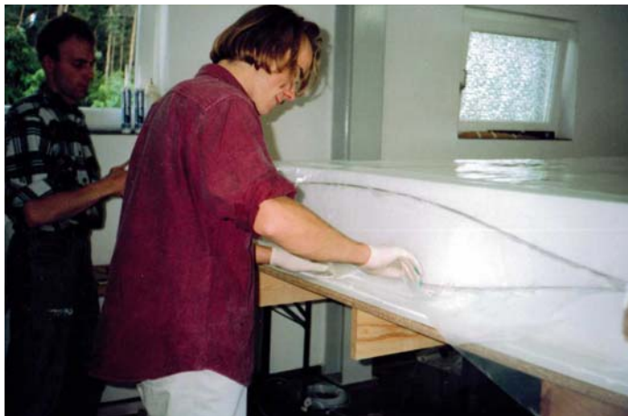
Bild 5.54: Beplanken des Styroporkerns im Unterdruckverfahren
