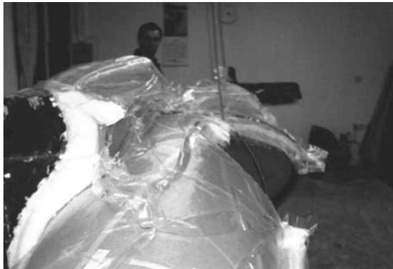
Bild 5.67: Verpressen der Wabenkerne im Vakuumverfahren
