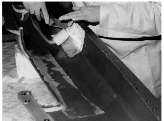
Bild 52: Einlaminieren zusätzlicher lokaler Verstärkungen.
