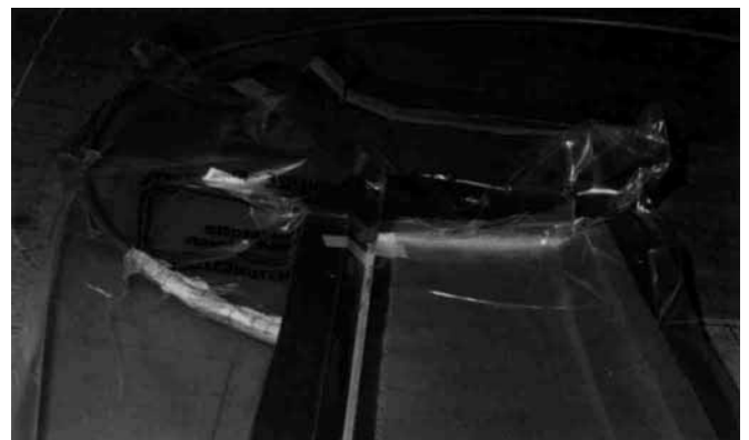
Bild 34: Damit sich die Vakuumfolie nicht am Schlauchende festsaugt, wird das Schlauchende perforiert und mit Abreißgewebe umwickelt.
