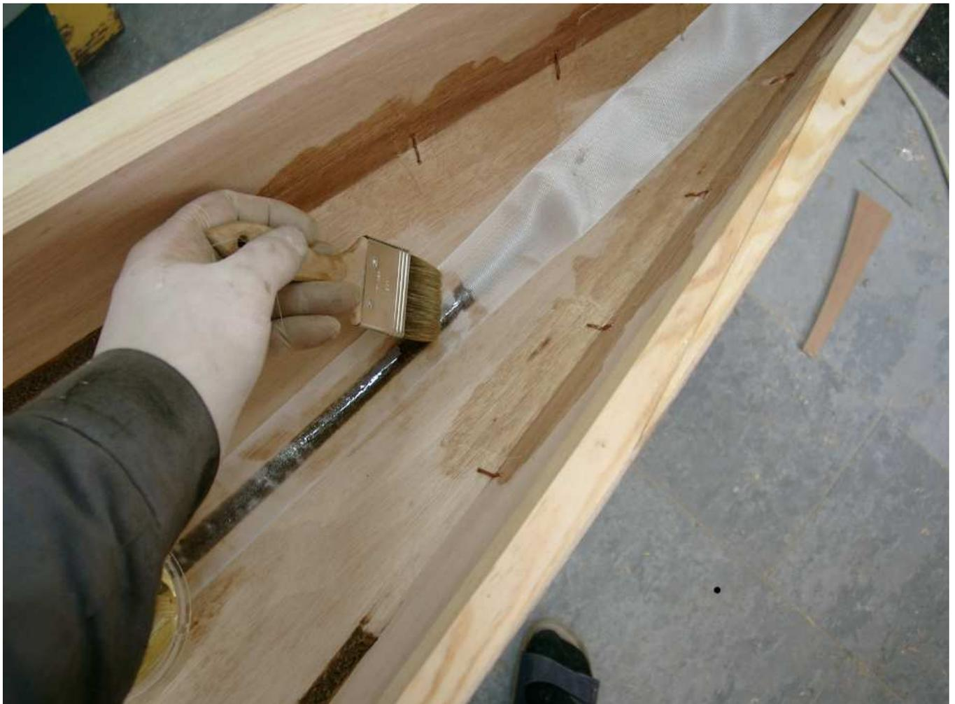
Während die Spachtelmaße noch klebrig ist, wird das Klebeband abgezogen und in alle Kanten ein Glasgewebband mit 120g/qm mit reinem Harz und einem Pinsel aufgestupft.
