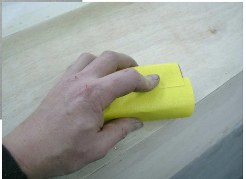
Wenn der Rumpf geschliffen ist und die Kanten schön verrundet sind, kann das Glasgewebe trocken auf den Rumpf gelegt werden. Im konkreten Fall kam ein Glashohlfasergewebe mit 160 g/qm zur Anwendung.
