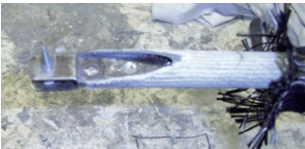
Teil im Rohr
