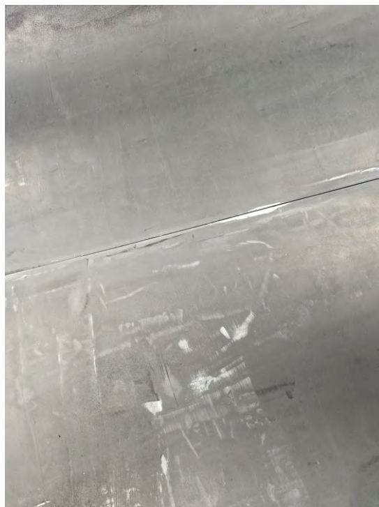
Abbildung 9 obere Hälfte: „fertig“ gespachtelt und geschliffene Oberfläche; unten: noch unebene Oberfläche durch die sogar noch der Formunterbau durch scheint
