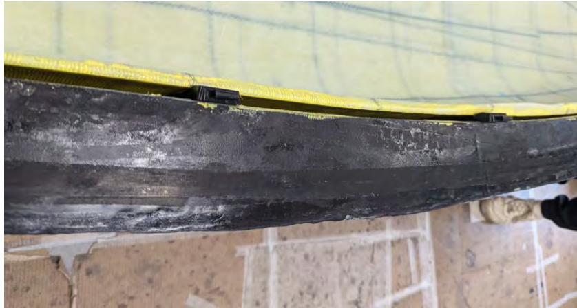
Abbildung 17 Entformungskeile zwischen Form und Bootswand
